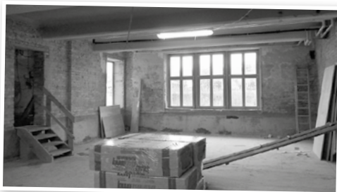
Rohbauzustand der „Turnhalle“
